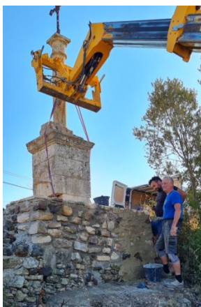
Route de la Bastide d'Engras Stabilisation de la croix Entreprise Toletti
